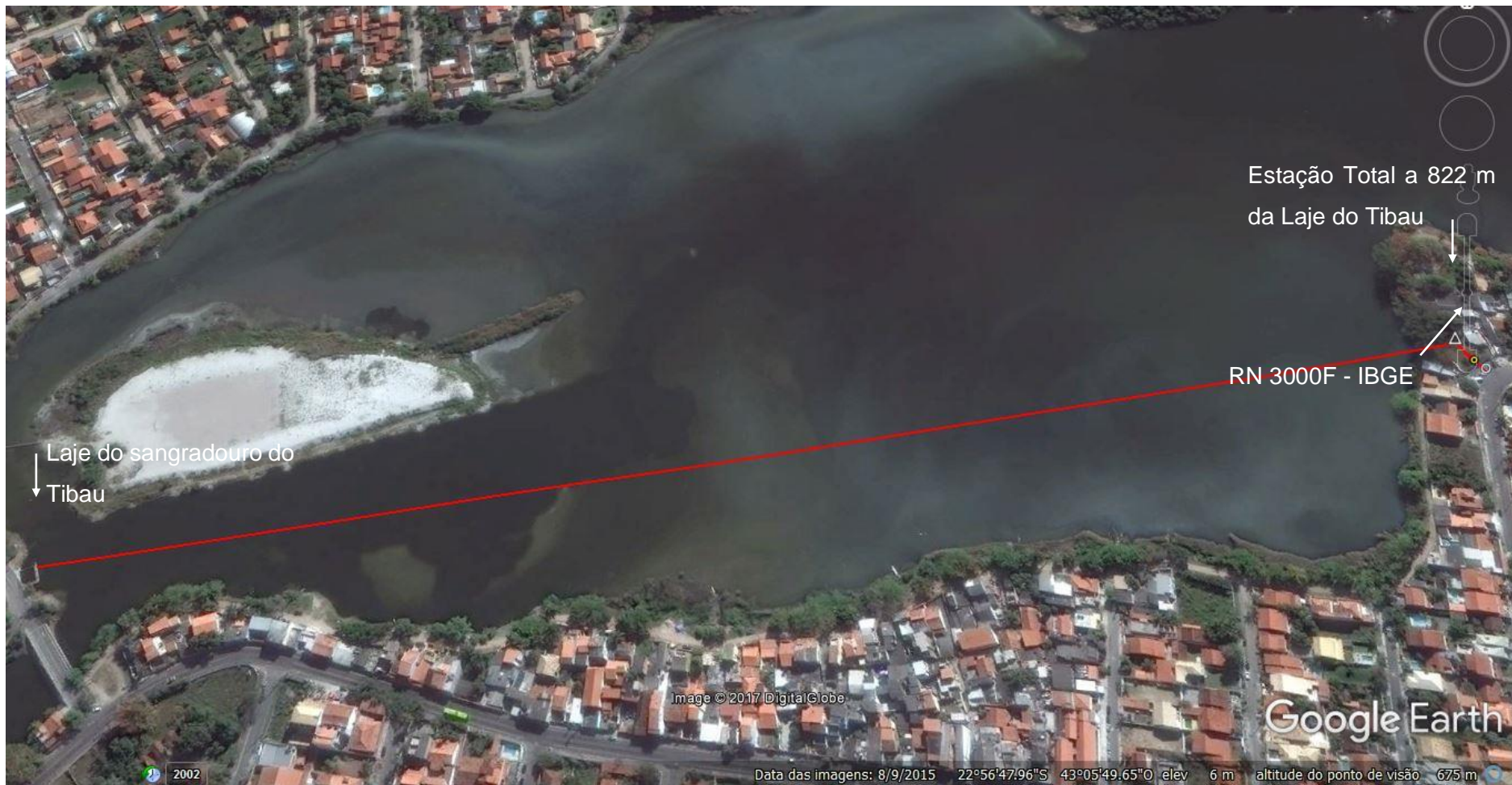
Figura 58 Leitura do RN 3000F, nivelamento da laje do vertedouro do Tibau. Determinação da altitude ortométrica da laje do sangradouro.
