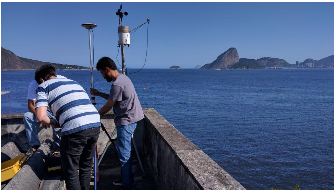
Figura 53 Montagem da antena fixa no telhado do prédio das Geociências.
