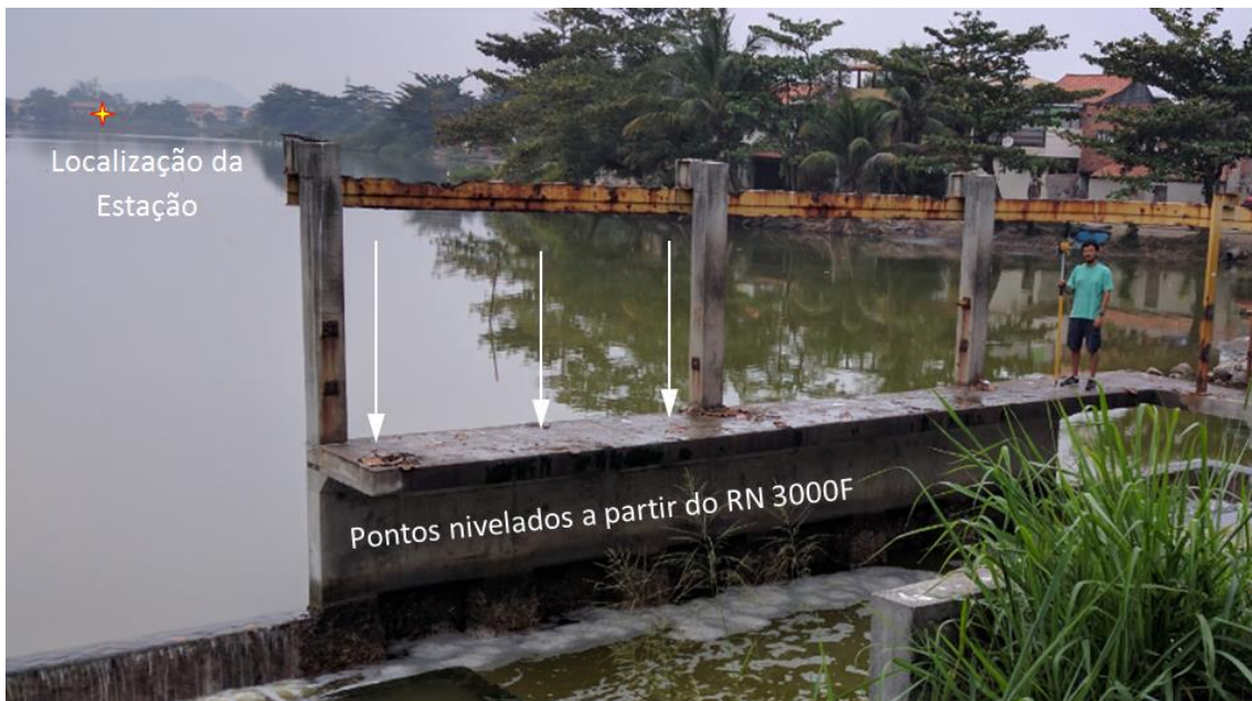
Figura 60 Foram feitas três visadas do RN 3000F para a laje do sangradouro.
