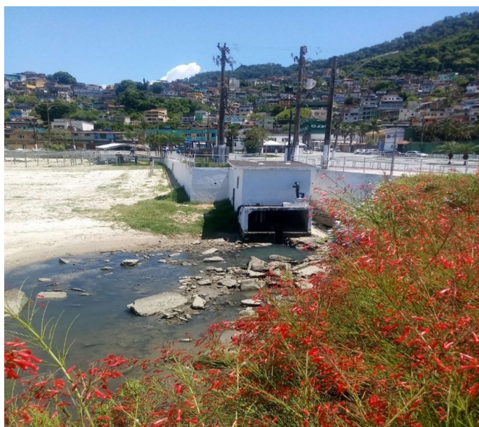
Figura 23: despejo de esgoto, Praia do Anil, Angra dos Reis
