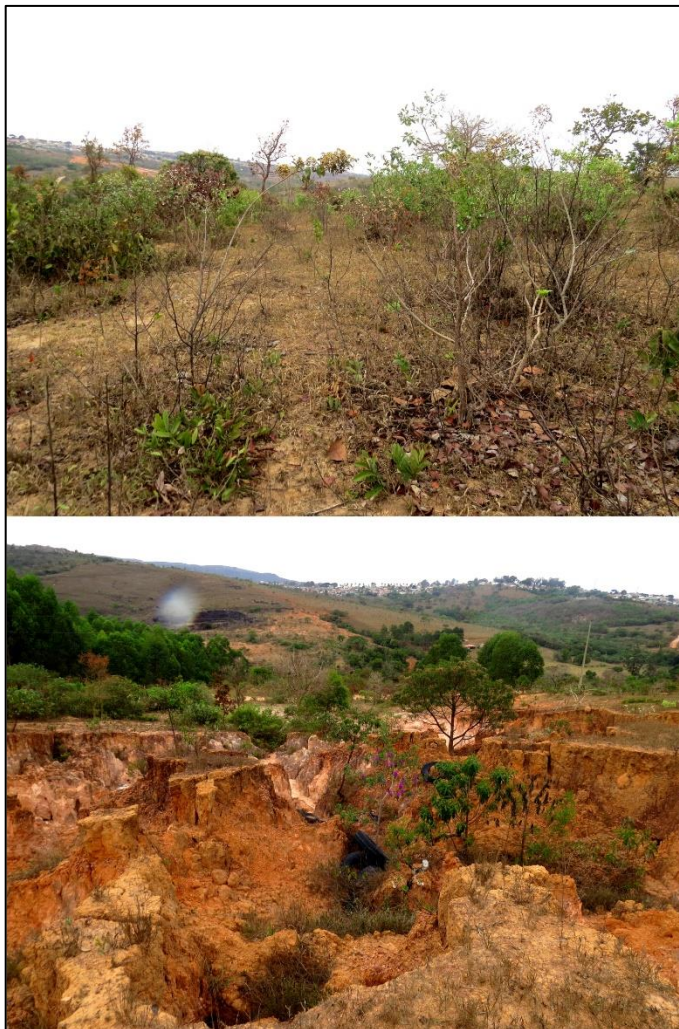
Figura 45 – Paisagem e cobertura vegetal com voçorocas próximas ao perfil. Foto: Coe, 2018.
