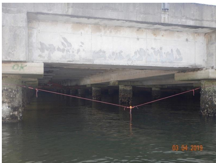
Figura 6 Sistema de amarração de duas pontas do ponto P-04 na estrutura portuária, realizado no canal do Porto de Santos, SP.
