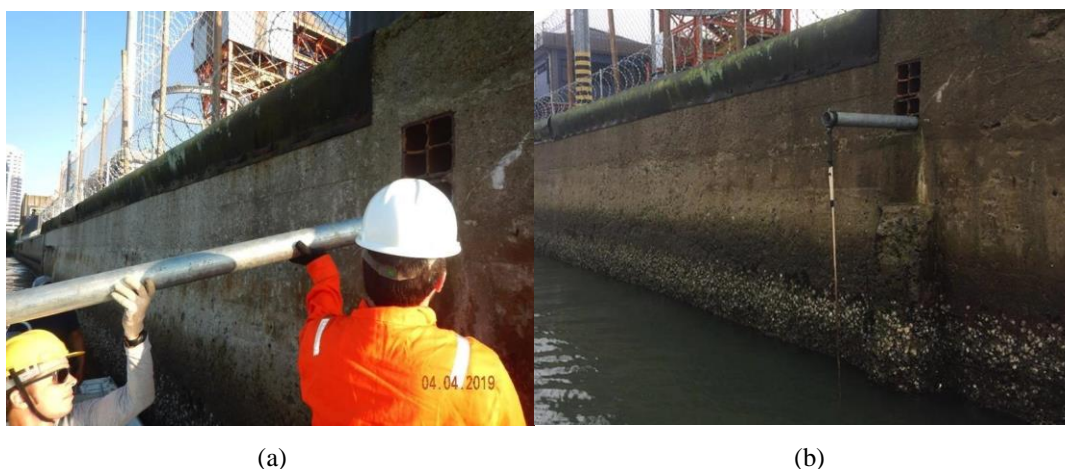
Figura 5 (a) Instalação da haste tubular (90 mm x 2 m) e (b) Cabo de placas fixado na haste tubular, ambos no ponto P-01 em uma estrutura portuária já existente no canal do Porto de Santos, SP.
