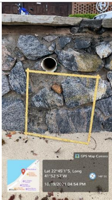
Figura 181: Cano de escoamento pluvial, muro de contenção
