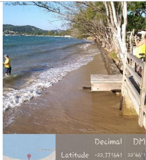
Figura 100: Estrutura artificial ao longo da faixa de areia
