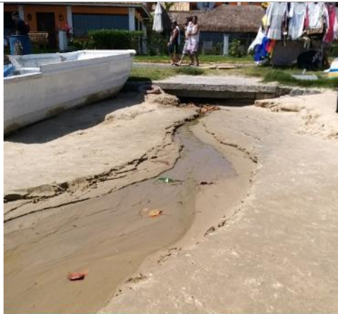
Figura 127: Saída de canal pluvial
