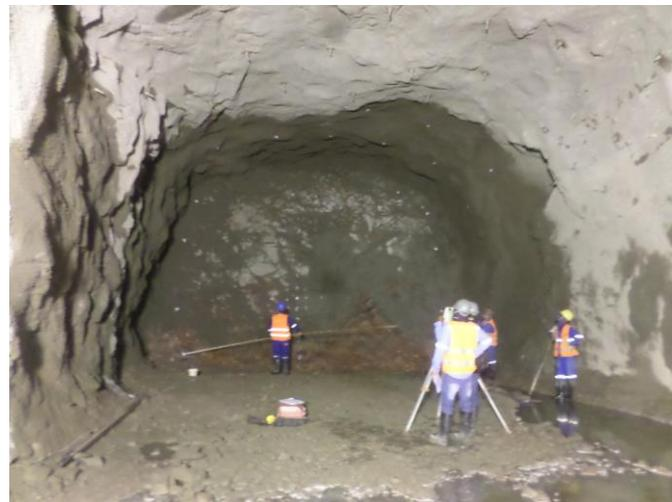
Figura 4.1.44- Região do Emboque-marcação do plano de fogo e dos tirantes pela equipe topográfica, tirada em 25/06/2018.
