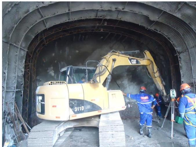
Figura 4.1.28- Região do Desemboque, durante instalação das cambotas 17° e 18°, tirada em 15/05/2018.
