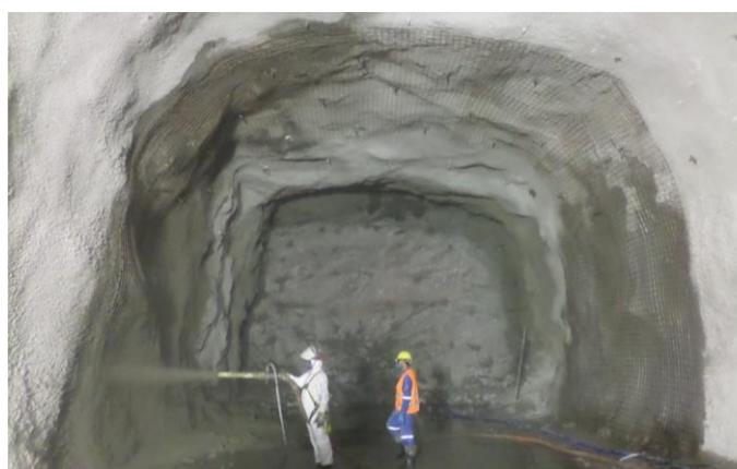
Figura 3.2.7- Durante aplicação de concreto projetado secundário, após aplicação de tela metálica, tirada em 14/06/2018.
