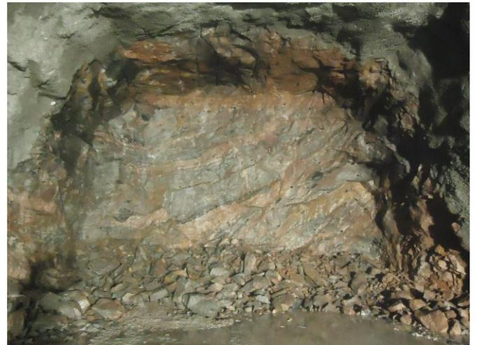
Figura 3.1.5- Região do Emboque- classe II, estaca 6081+9,20, contorno em boas condições tirada em 05/06/2018.
