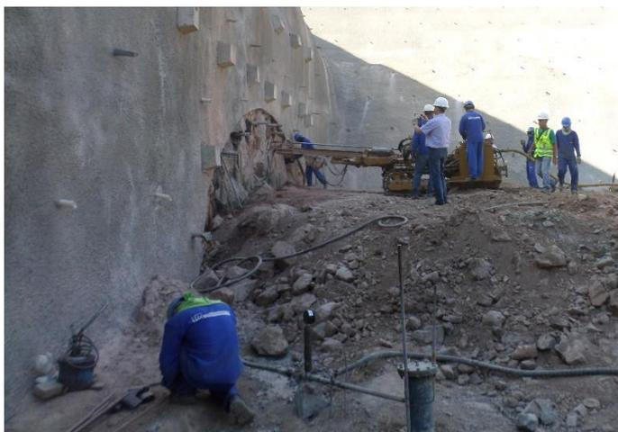
Figura 4.1.19- Região do Desemboque, em função da dificuldade para inserir os tubos, foi necessário alargar os furos com a perfuratriz PW, para instalação do tubo TCH-40, tirada em 05/03/2018.
