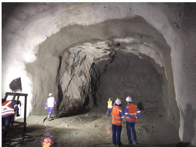
Figura 4.1.47- Região do Emboque- após aplicação de concreto projetado no tratamento secundário, tirada em 01/08/2018.
