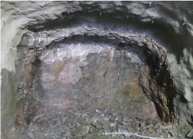
Figura 3.1.4- Região do Emboque- classe II, estaca 6080+8,7, contorno em boas condições- tirada em 25/05/2018.
