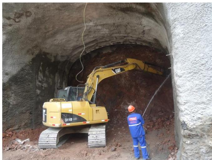
Figura 4.1.26- Região do Desemboque- durante bate choco mecanizado. Em abril foram escavados 9,37 metros e instaladas 10 cambotas no total, tirada em 28/04/2018.
