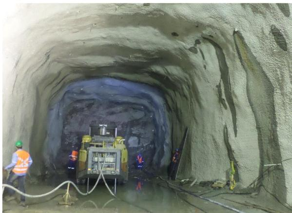
Figura 4.1.15- Região do emboque- classe II, no Km 121,620. Pontos de água umidade/gotejamento leve na parede direita, tirada em 13/06/2018.
