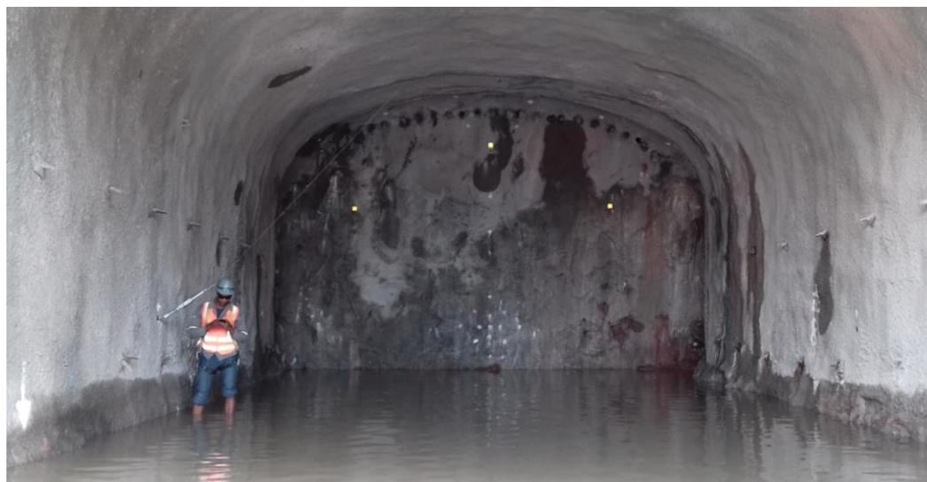
Figura 3.3.3- Durante leitura da seção de convergência, na região do Desemboque, tirada em 05/07/2018.
