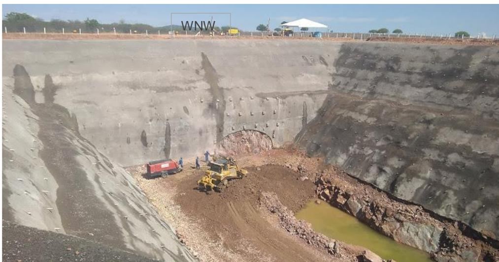
Figura 4.1.18- Região do Desemboque- tratamento dos taludes frontal e lateral em fase de conclusão, tirada em 22/02/2018.
