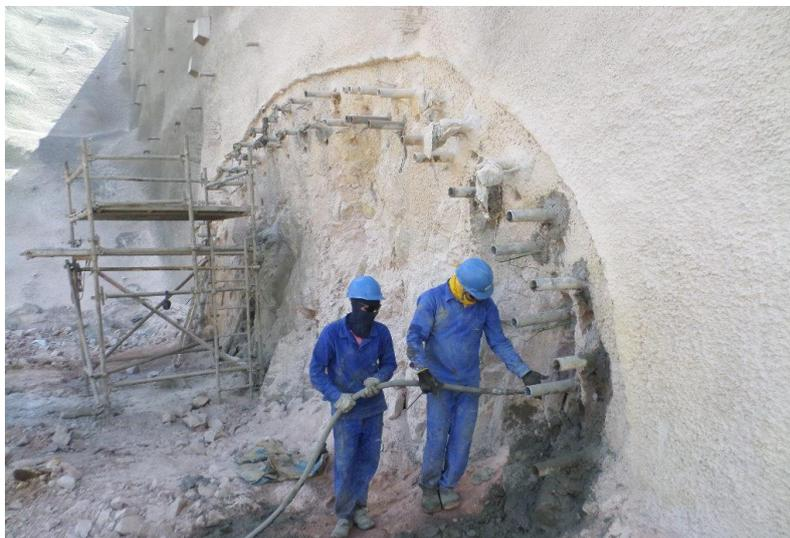
Figura 4.1.38- Região do Emboque-durante execução da primeira campanha de enfilagem injetada com Tubo TCH-40, tirada em 26/03/2018.
