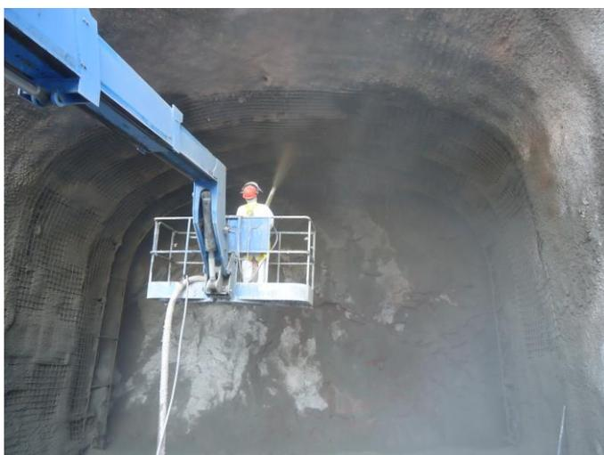
Figura 4.1.25- Região do Desemboque- durante aplicação do concreto projetado no trecho camboteado, tirada em 26/04/2018.
