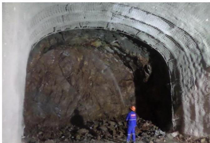
Figura 4.1.41- Região do Emboque-limite do tratamento S5 (trecho camboteado- 10 cambotas instaladas), com o tratamento S3, tirada em 04/05/2018.
