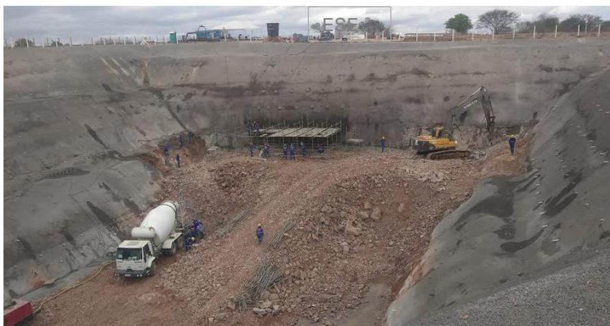
Figura 4.1.35- Região do Emboque-tratamento para estabilidade dos taludes, frontal e lateral, conforme projeto, tirada em 16/02/2018.
