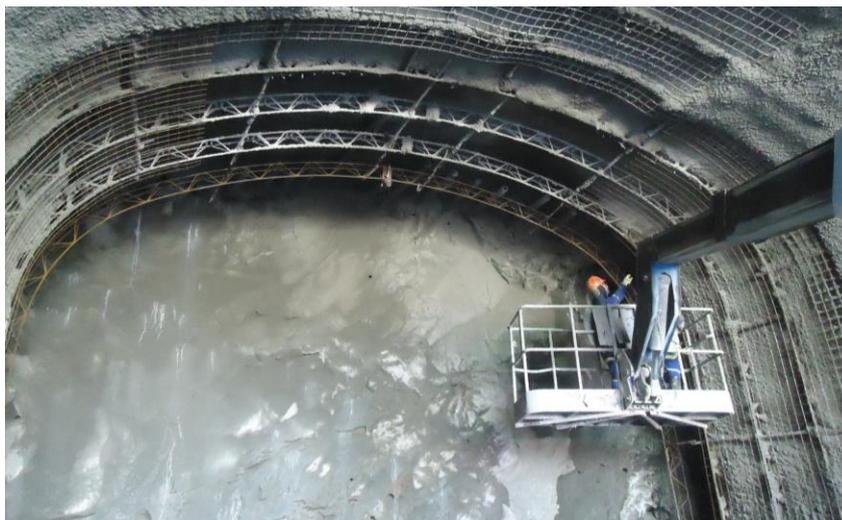
Figura 3.2.4- Região do Desemboque- Classe V, durante instalação das cambotas, tirada em 16/05/2018.
