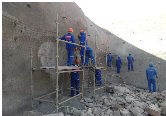
Figura 4.1.37- Região do Emboque-durante instalação de tela Q138, conforme projeto, tirada em 21/02/2018.
