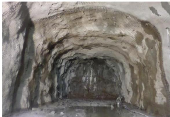
Figura 4.1.16- Trecho em classe IV, no Km 121,750. Apresenta pontos de água umidade/gotejamento leve associado ao intenso fraturamento da região, tirada em 30/07/2018.
