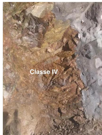
Figura 4.1.9- Lado direito com intenso fraturamento e alteração, classe IV- A3C3F4, tirada em 01/08/2018.
