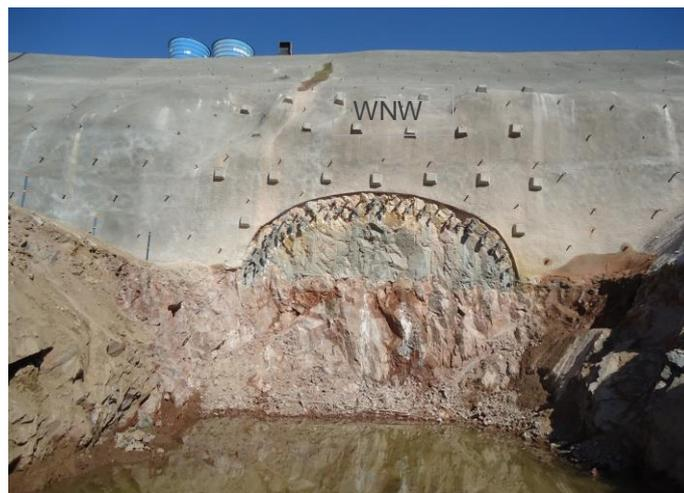
Figura 4.1.20- Após execução das enfilagens, foi realizada a detonação na região do desemboque, a fim de alcançar a cota do piso para prosseguir com a escavação do túnel, tirada em 21/03/2018.
