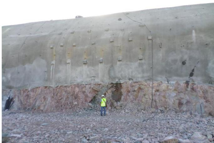
Figura 4.1.36- Região do Emboque- tratamento para estabilidade dos taludes, frontal e lateral, conforme projeto, tirada em 21/02/2018.
