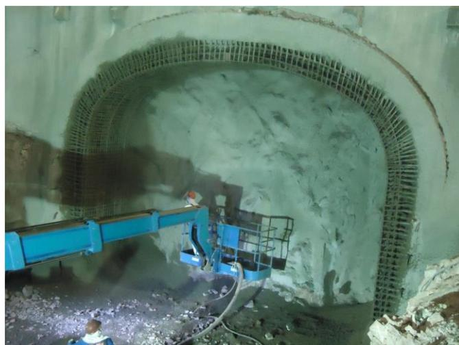
Figura 4.1.40- Região do Emboque- após a primeira detonação, e durante a aplicação de concreto projetado na viga portal, tirada em 19/04/2018.
