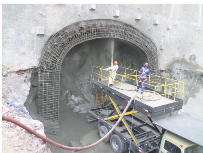
Figura 4.1.22- Região do Desemboque, aplicação de concreto projetado na viga portal, tirada em 29/03/2018.
