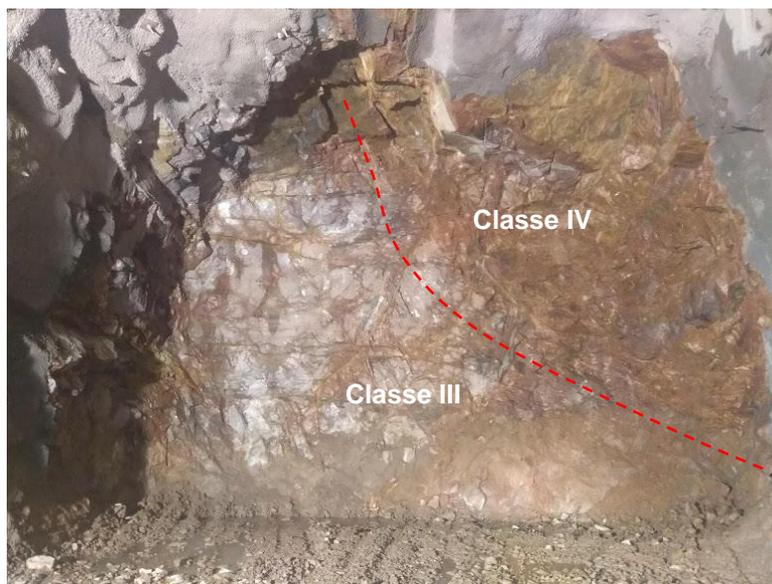
Figura 4.1.8- Região do emboque- classe IV, no Km 121,749. Contato geotécnico, classe III lado esquerdo e classe IV no lado direito da seção, tirada em 01/08/2018.
