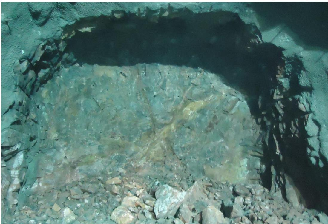
Figura 4.2.14.1– Região do Emboque, classe II- Tratamento S2, estaca 6080+12- Rocha são com fraturas A1C1F2, contorno em boas condições, tirada em 26/05/2018.
