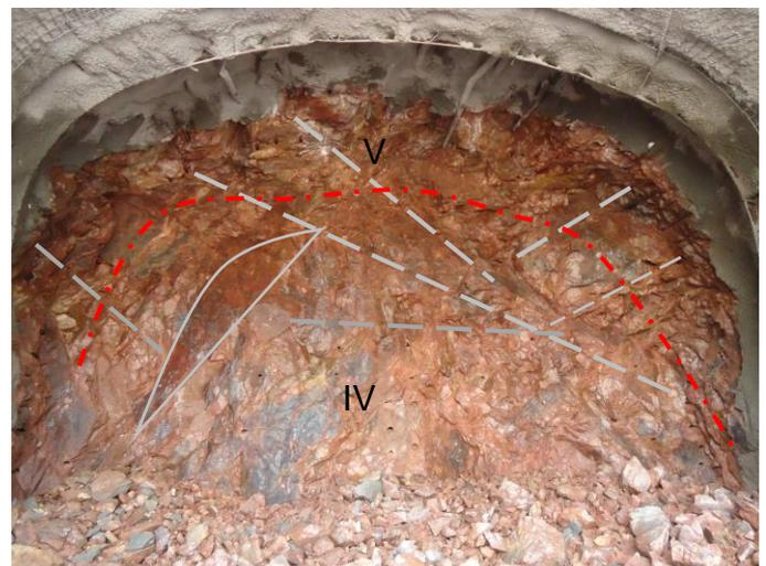
Figura 3.1.9- Região do Desemboque- classe V, estaca 6014+10,74, contato geotécnico classes V/IV tirada em 28/04/2018.
