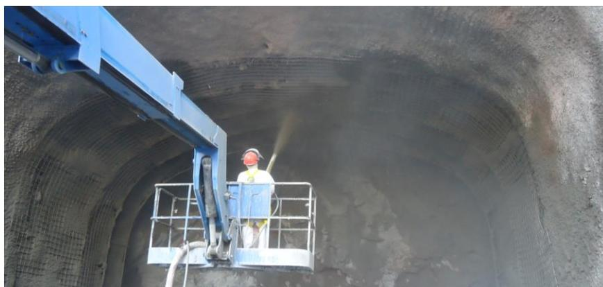
Figura 3.2.5- Região do Desemboque- classe V, durante aplicação de concreto projetado no trecho camboteado, tirada em 26/04/2018.
