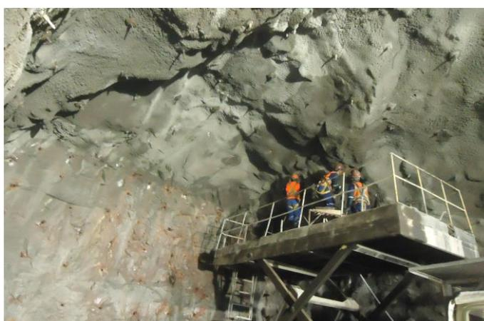
Figura 3.2.6- Região do Emboque- classe IV, durante instalação dos tirantes, tirada em 01/08/2018.
