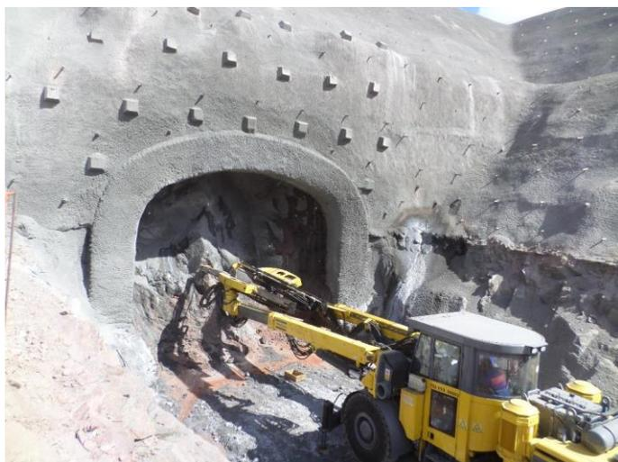
Figura 4.1.23- Região do Desemboque, Perfuração com jumbo para fogo de regularização da frente, tirada em 04/04/2018.
