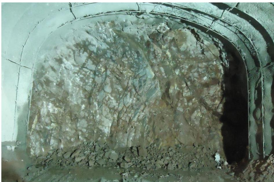
Figura 4.2.13.1- Frente do Emboque, classe III- Trecho camboteado, com aproximadamente 8,0 metros de túnel escavado- Intenso fraturamento, rocha são- A1C1F3, tirada em 02/05/2018.
