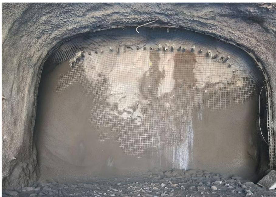
Figura 4.1.31- Região do Desemboque-aplicação de tela Q138, e projeção de 10cm de concreto projetado, na região frontal, conforme recomendações técnicas para paralisação do túnel, tirada em 10/08/2018.
