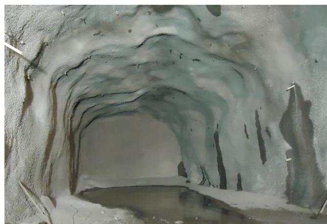
Figura 4.1.49- Conclusão do tratamento para paralisação do túnel, conforme recomendações técnicas para paralisação do Emboque, tirada em 16/08/2018.
