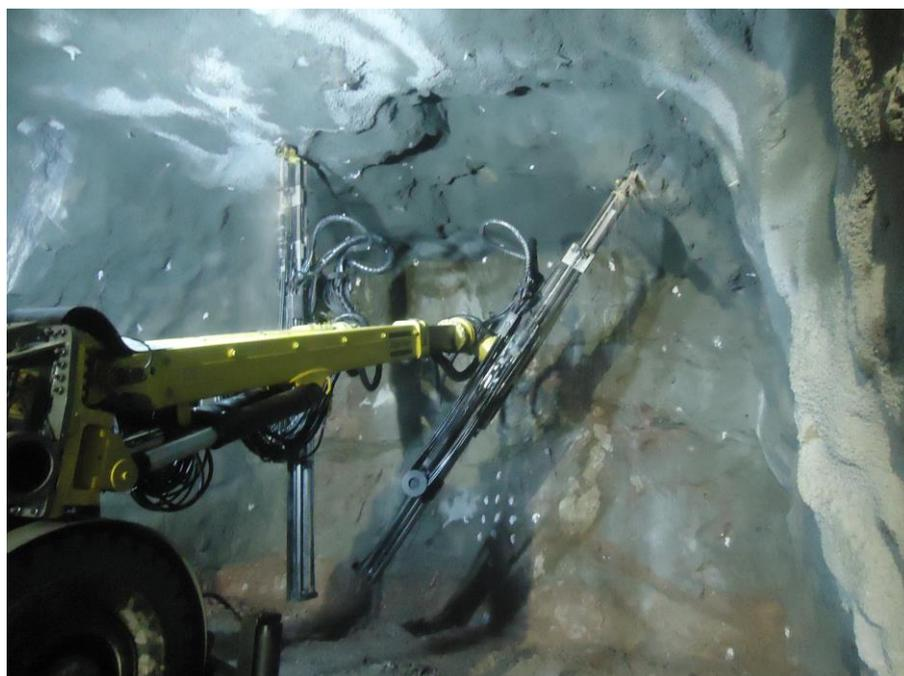
Figura 4.1.46- Perfuração com 3,0m para instalação dos tirantes, tirada em 25/07/2018.
