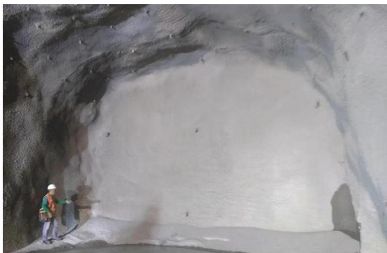
Figura 6.2- Conclusão do tratamento, com aplicação de concreto projetado secundário conforme recomendações para paralisação do túnel, tirada em 15/08/2018.
