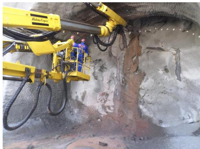
Figura 4.1.24- Região do Desemboque, durante execução da segunda campanha de enfilagem Auto Perfurante, perfuração com jumbo- 25 furos de 12,0m cada, tirada em 09/04/2018.
