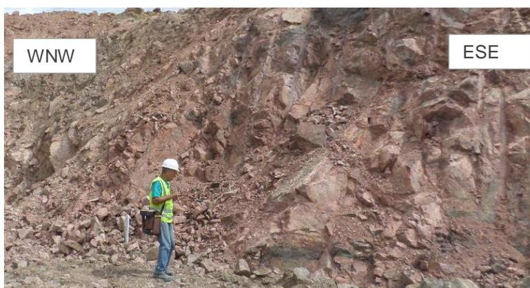
Figura 4.2.1- Identificação das principais estruturas, nos taludes, na região de influência do desemboque (lado leste), onde apresentam intenso fraturamento, tirada em 03/03/2018.
