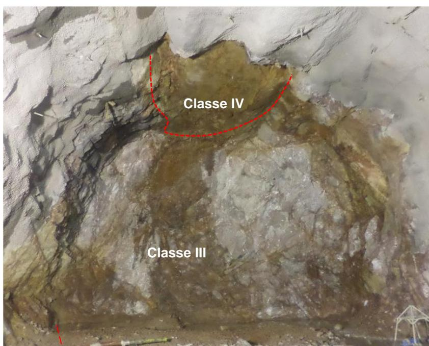
Figura 4.1.12- Região do emboque- Classe III, no Km 121,694, tirada em 04/07/2018.
