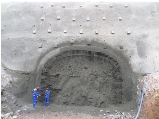
Figura 4.1.39- Região do Emboque-durante execução da viga portal, tirada em 12/04/2018.
