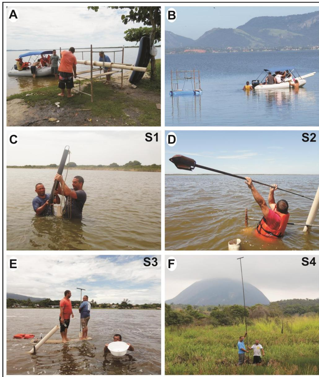
Figura 15 – (A e B) Montagem e deslocamento da plataforma e dos equipamentos necessários para a sondagem. (C, D, E e F) Locais de perfuração das sondagens (C) com a sonda e (D, E e F) com o trado mecânico utilizados na coleta de sedimentos.
